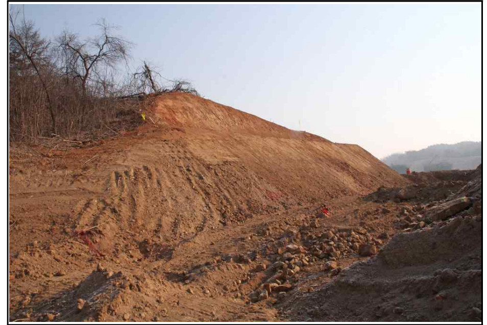
【그림 4】 깎기비탈면 종점부 측면 사진
