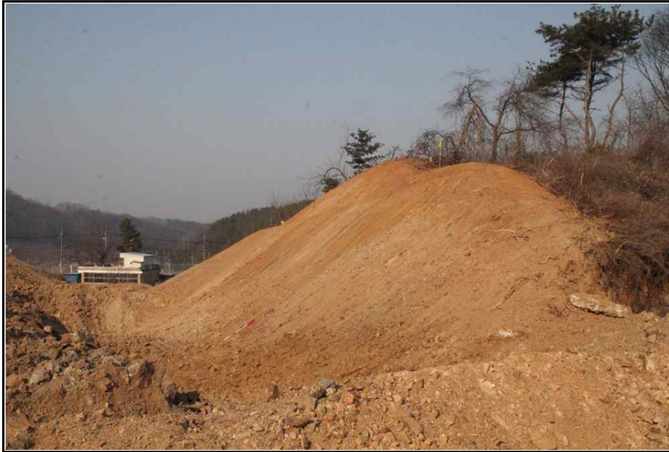
【그림 3】 깎기비탈면 시점부 측면 사진
